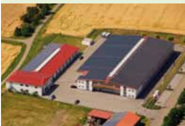
Photovoltaikanlage auf den Firmendächern
